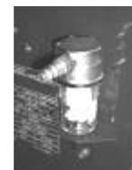
Filtre pneumatique, raccordement du réseau pneumatique
