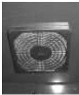
Ventilator mit Staubfilter
