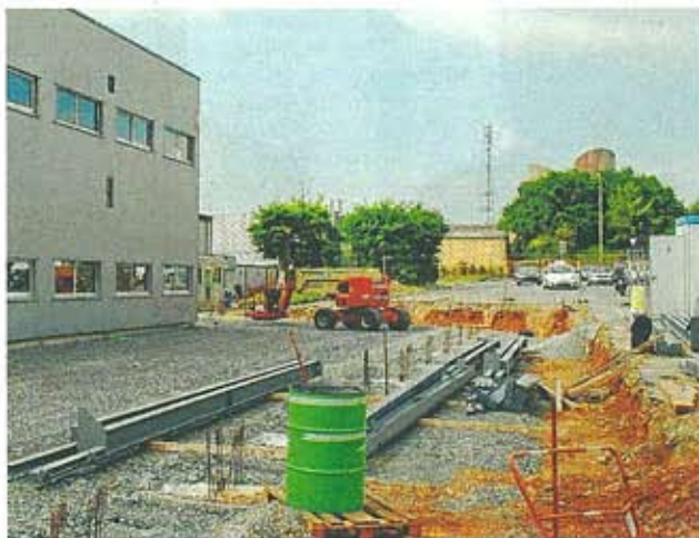
Le chantier à Saint-Berthevin. D'après Bruno Bouygues, Gys n'est pas près de bouger de la Mayenne : « on n'est peut-être pas les mieux positionnés géographiquement, mais ici on a trouvé des gens prêts à partager une aventure industrielle ».
